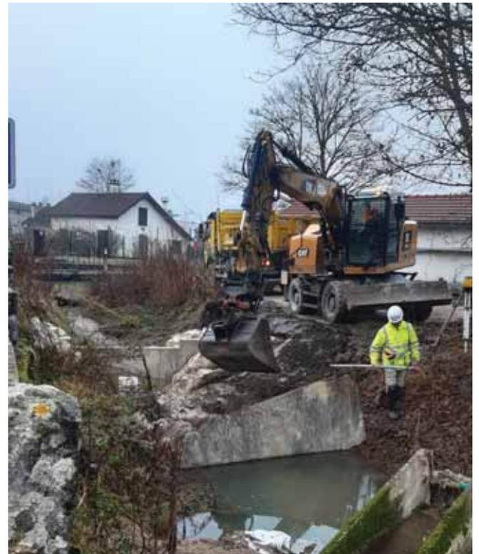
Figure 2 : A gauche : Réalisation des fondations du nouveau dalot à Pillaud Matériaux.
