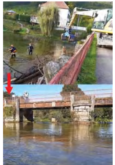
Pont du Moulin Neuf (Bayel).
