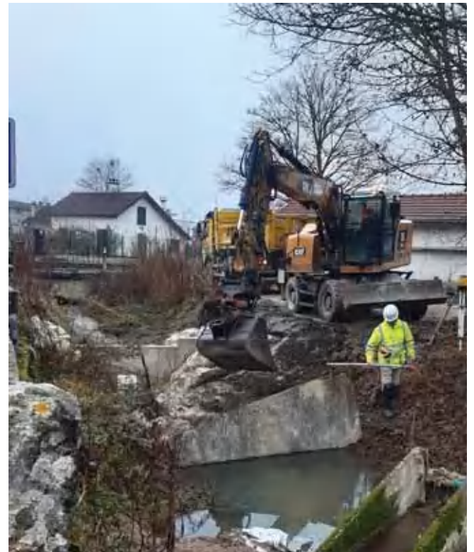
Figure 2 : A gauche : Réalisation des fondations du nouveau dalot à Pillaud Matériaux. A droite : Aménagement de l'ouvrage répartiteur en le bras de Bresse et le fossé SNCF.
